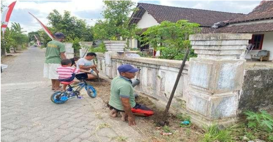
Gambar 7. Proses Pembuatan Lubang Biopori di Dusun Tanjung
