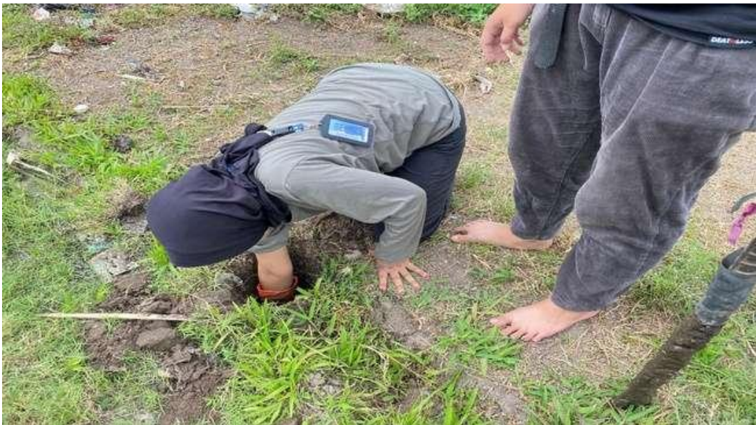
Gambar 8. Proses Pembuatan Lubang Resapan Biopori di Dusun Tanjung
